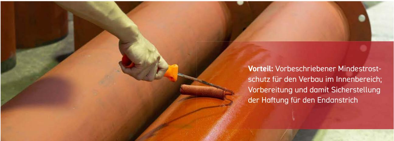
**Vorteil:** Vorbeschriebener Mindestrostschutz für den Verbau im Innenbereich; Vorbereitung und damit Sicherstellung der Haftung für den Endanstrich
